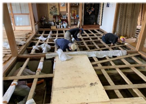
床下の泥かき作業の様子(大町町)
